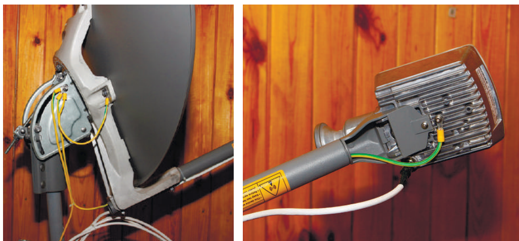
Рисунок 29 – Крепление проводников заземления на антенне 0.74м
