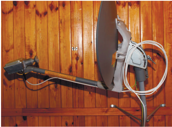
Рисунок 31 – Прокладка коаксиального кабеля
